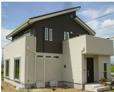
《完成現場見学会 建物外観》
