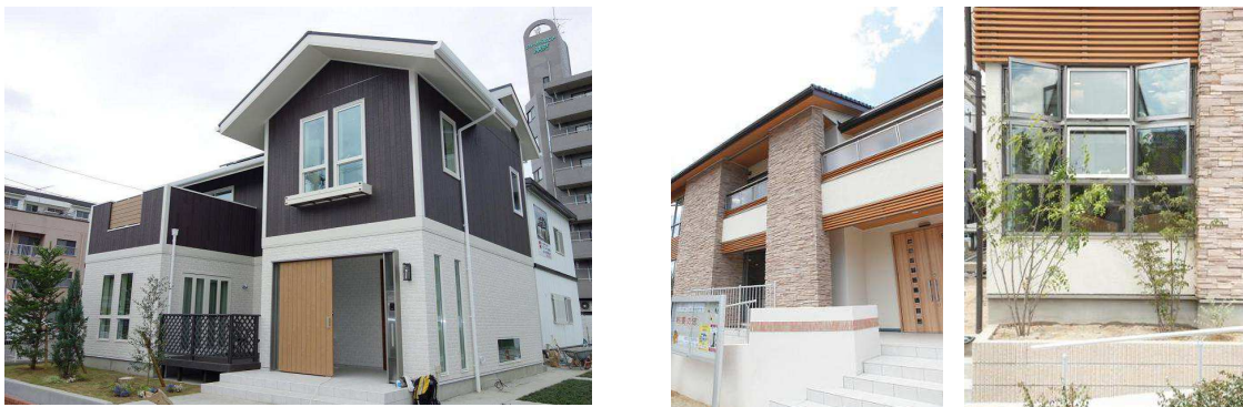
<フィアスホーム「arietta(アリエッタ)」外観>
