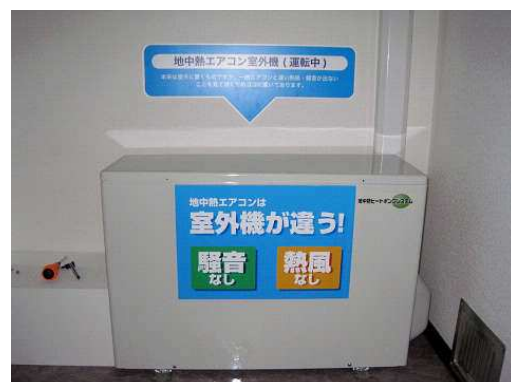
《地中熱エアコン／室外機》
