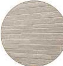
国産木材の製材後の端材などを木材チップに加工。それを原料にしてつくった窯業系サイディングを外壁に使っています。
