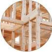
構造材に国産のヒノキの集成材を使用。建てた後も、強く、曲がりにくく、長持ちする安全な構造材です。
